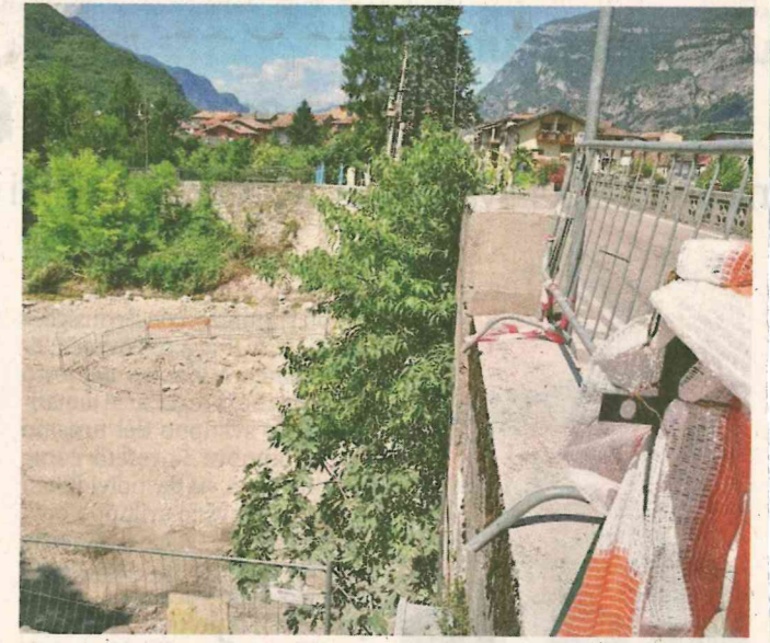
I lavori alla passerella ciclopedonale sul rio Cavallo a Calliano
