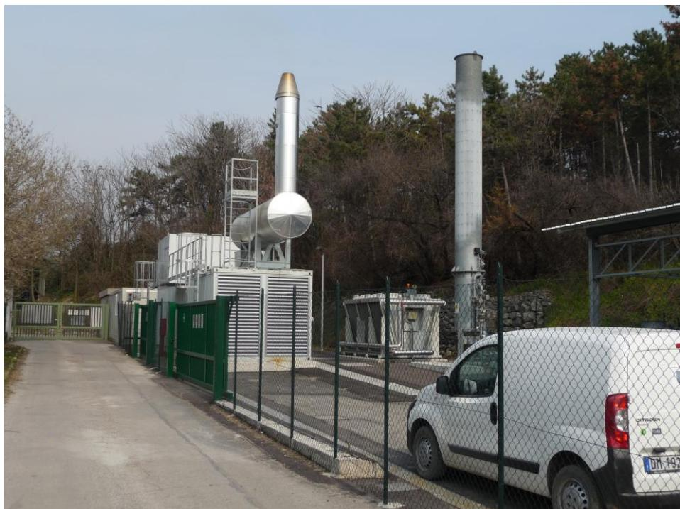
In alternativa al prescritto impianto di combustione in torcia del biogas prodotto presso la discarica dei Lavini, a seguito dell'attivazione di un project financing, nel corso del 2008 è stato realizzato e messo in esercizio l'impianto di cogenerazione alimentato dal biogas che, estratto dai bacini dei lotti 1° e 2°, è convogliato alla centrale attraverso una rete di tubazioni superficiali.
